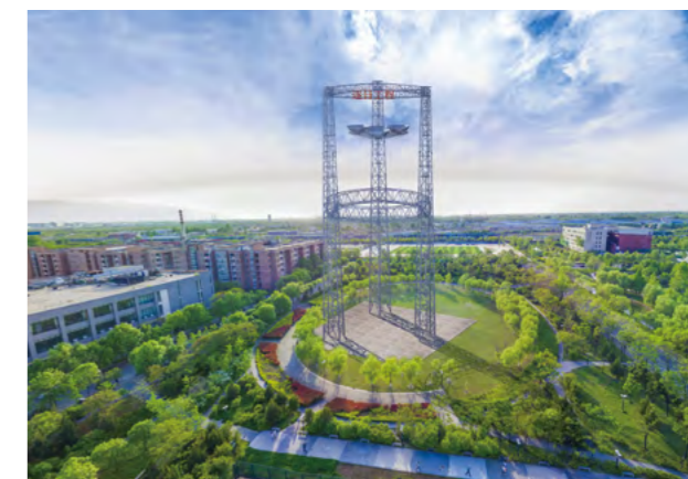
“逐日工程”——学院科研团队研制的全链路全系统空间太阳能电站地面验证系统
